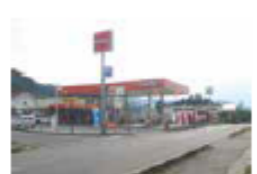
第3中継所:オートバブル上伊那東部中央給油所
